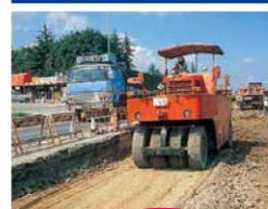
改良手順5(転圧)
