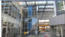
普通教室棟と生涯学習棟をつなぐブリッジがある
