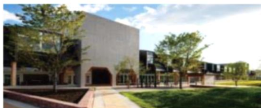
官民複合施設「オガールプラザ」外観
