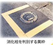
消火栓を判別する黄枠
